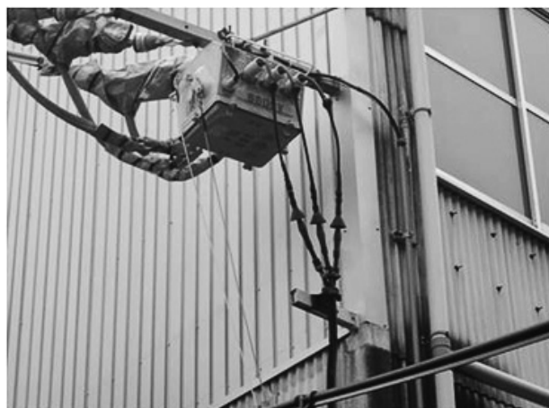
二次側の絶縁シートが取り外された高圧気中開閉器
