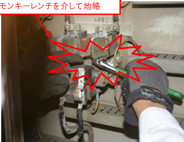
事故時の作業状況
