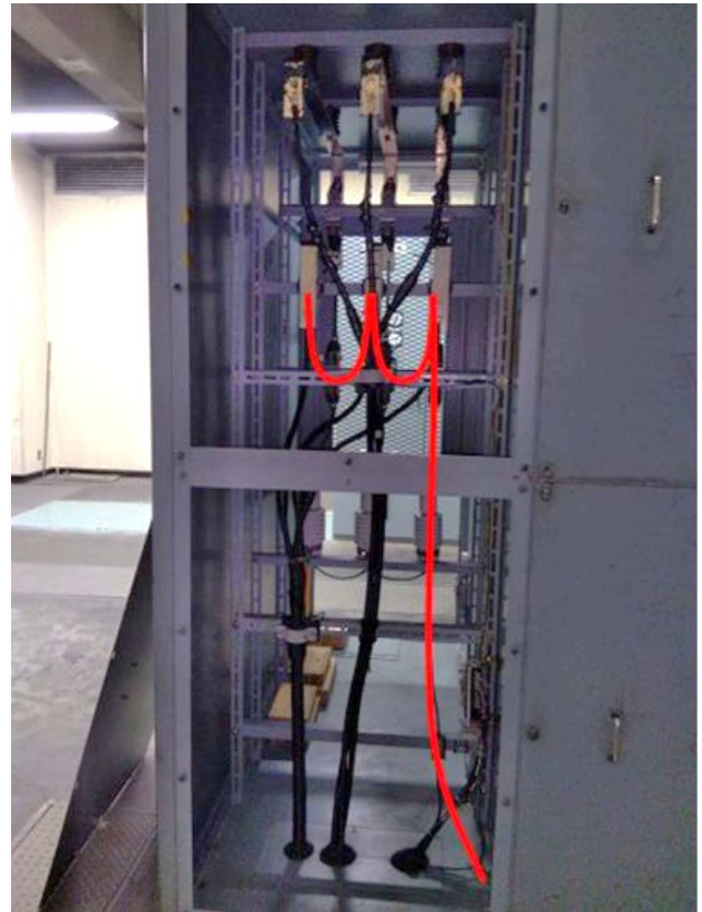
ショートアース設置状況
