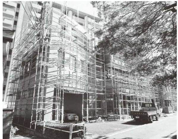
足場の設置状況
