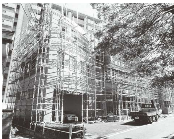
足場の設置状況
