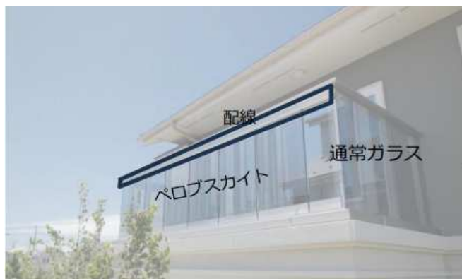
窓や壁面に ガラス建材一体型 として設置
