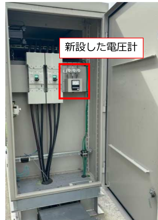
改修後の状況
