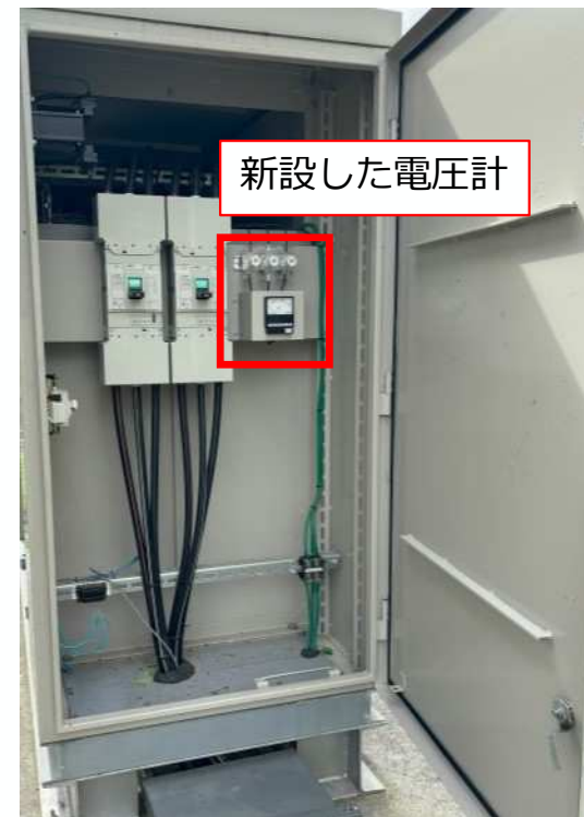
改修後の状況
