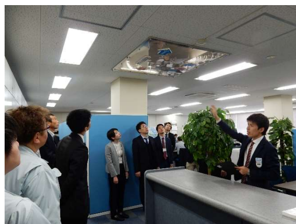
▲ ダイキン工業株式会社福岡ビル内の見学の様子
